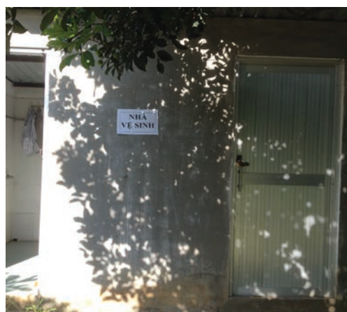
Hình 10. Nhà vệ sinh tự hoại
